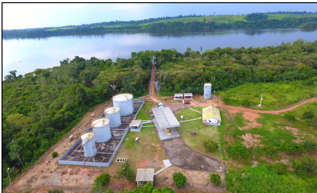
Foto 1. Vista aérea da base de distribuição de combustíveis.
